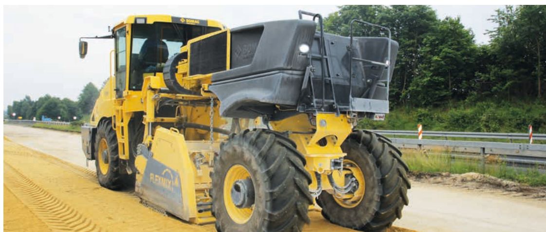
Asportazione di uno strato portante trattato con legante idraulico.
